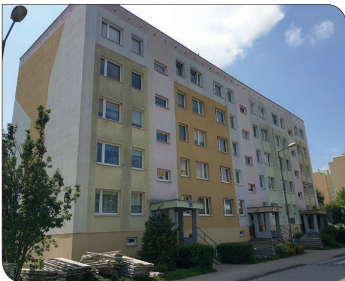
os. Różane 9 - elewacja przed
