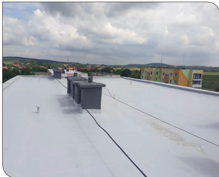
Dach - ul. Staszica 38-42
