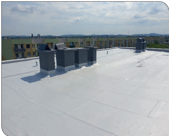
Dach - os. Różane 12
