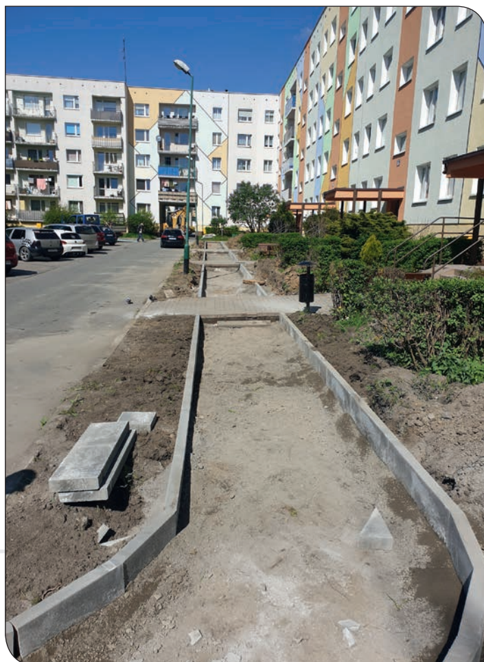
Chodnik os. Różane 39-40 w trakcie
